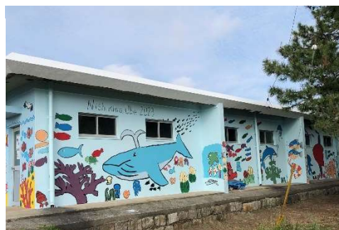
白土海水浴場シャワールーム
